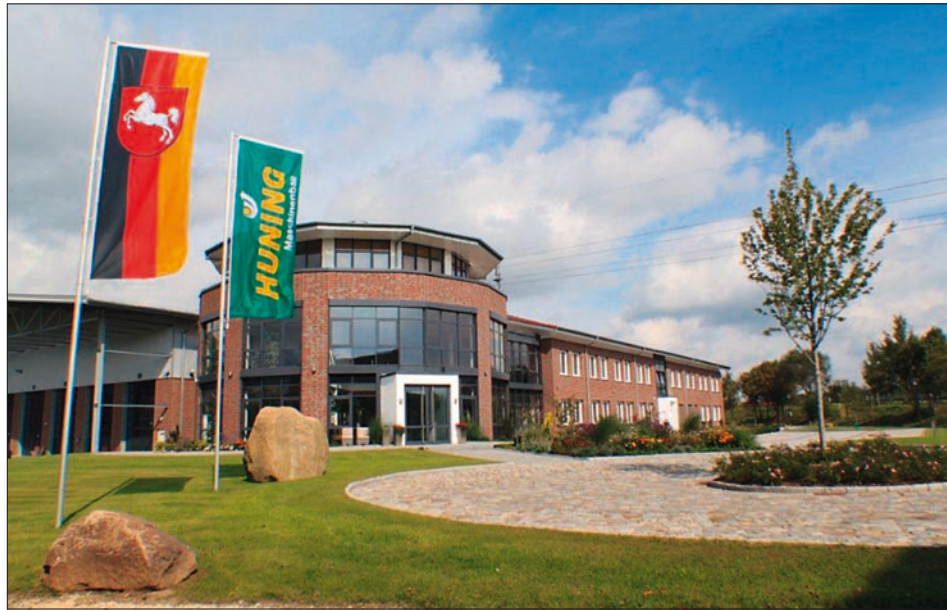
Die Huning-Unternehmensgruppe sicherte sich ein Darlehen aus dem ERP-Umwelt- und Energieeffizienzprogramm der KfW für eine neue Gewerbehalle.
